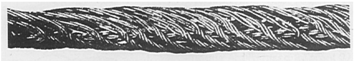
Abb. 9 - Abgeflachtes Teilstück eines Seiles mit vielen Kardeelen, das von der unrichtigen Abwicklung der Trommel verursacht wurde. Zu berücksichtigen ist die größere Aufwicklungslänge der äußeren Schicht der Kardeele. Es wird auch ein Spannungsungleichgewicht bei der Ladebedingung geben. Bedingung, die den sofortigen Austausch erfordert.
