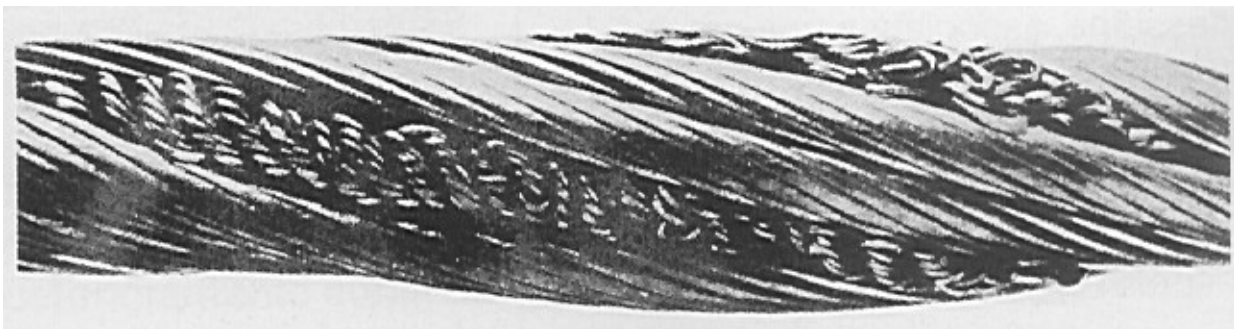
Abb. 6 - Örtlich begrenzte Erhöhung des Durchmessers eines Seils mit Parallelwicklung, verursacht durch die Verzerrung der Seele, verursacht durch eine plötzliche Last. Bedingung, die den sofortigen Austausch erfordert.
